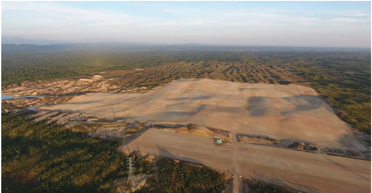
แผนภาพที่ 2-6: ภาพถ่ายพื้นที่ของโครงการไฟฟ้ามินบูจากมุมสูง
